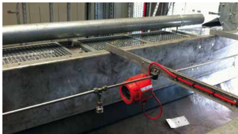
Mise en situation
