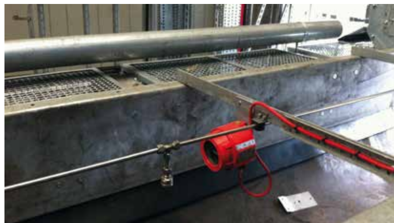
Mise en situation
