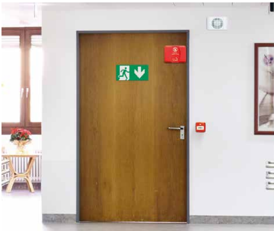
Mise en situation
