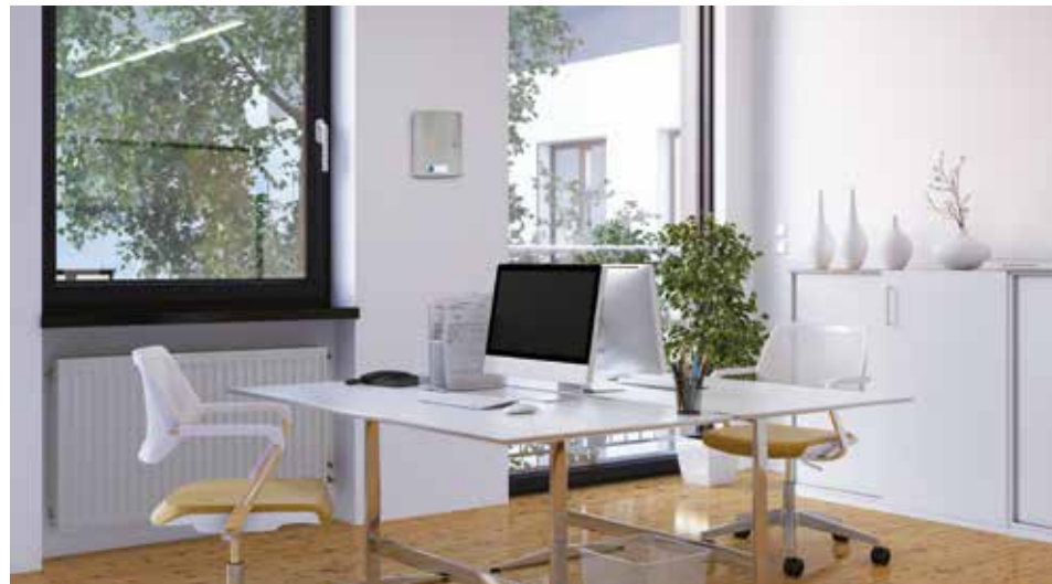
Installation en open space
