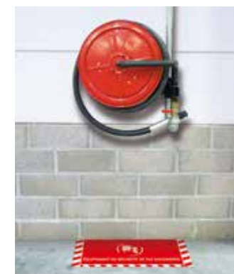
Mise en situation
