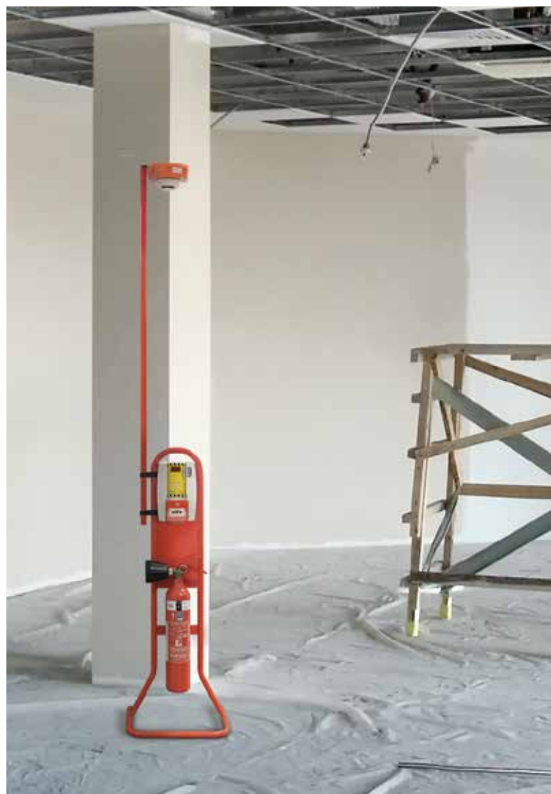
Mise en situation
